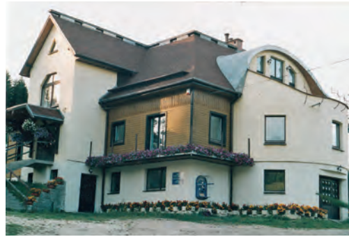
Das von Pfr. Witczak begonnene Pfarrhaus und Gemeindezentrum Foto: Günther Gröger
