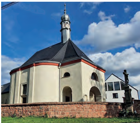
Kapelle am Annaberg. Hinter der Kapelle entsteht ein neues Haus (re.) zur Bewirtung der Besucher:innen mit einer wunderbaren Aussicht. Foto: Horst Ulbrich
